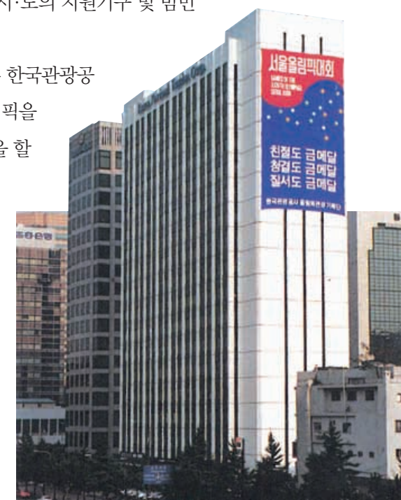
가로 15미터 세로 25미터 대국민 홍보용 올림픽 대형 현수막 설치
